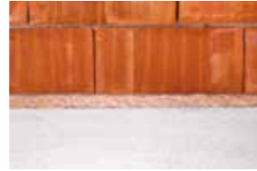
Los tabiques se levantan sobre una tira de Celenit N de 25 mm.
